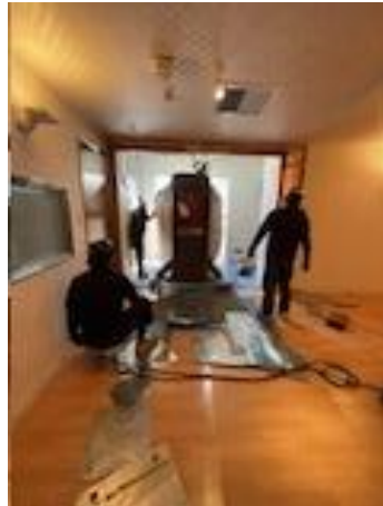
磁石部分を取り壊した壁から搬出
