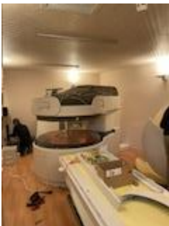
既存装置を磁石部分のみとする分解作業
