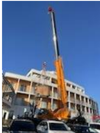
磁石部分(十数トン)を大型クレーンにて搬出
